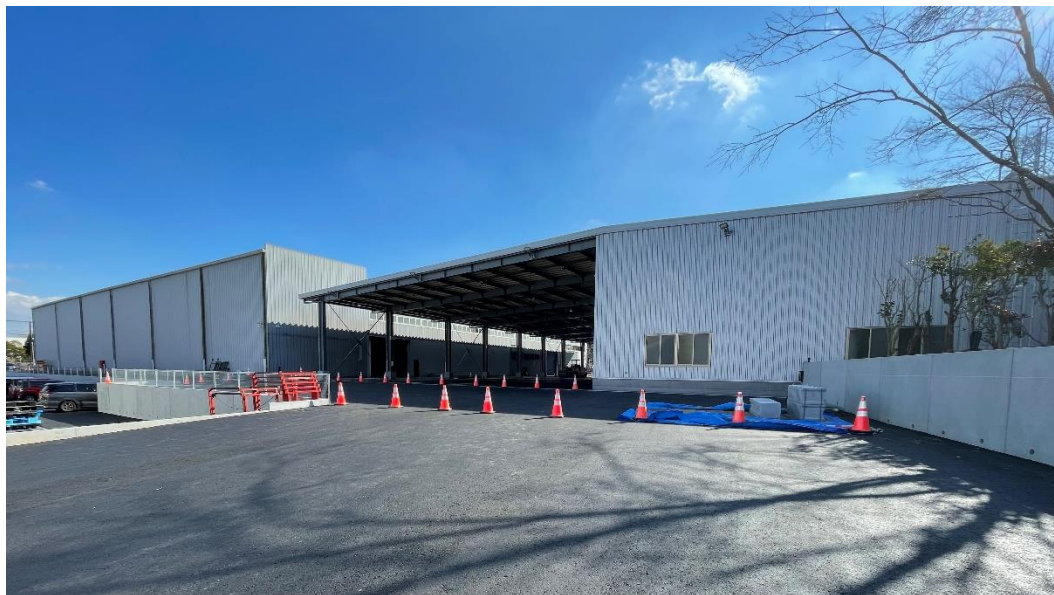
成田南部第2物流センターB棟 全景
